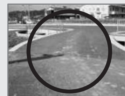
○ 泥を除去している
